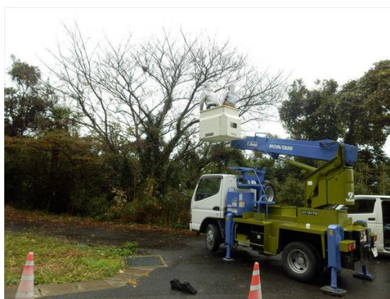
<高所作業車の使用（長崎県対馬市）>
